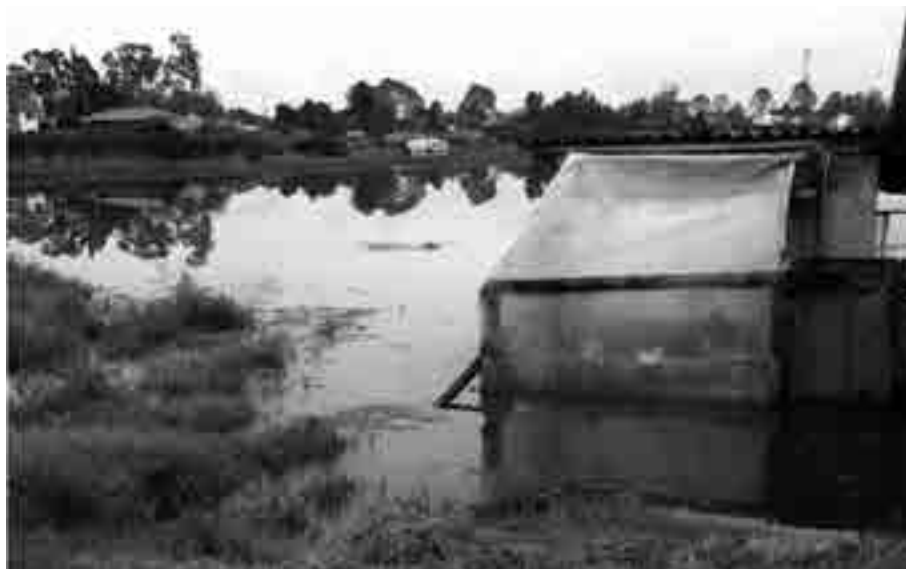
Figura 1. Cocina afectada por desbordamiento de río, involucrando la seguridad alimentaria. Vereda Parcelas, municipio de Cota (Cundinamarca)
