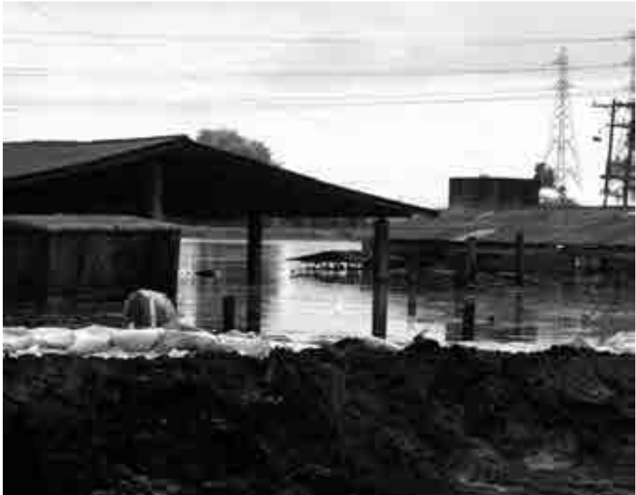
Figura 4. Afectación de instalaciones para animales (pesebreras al fondo y a la derecha) y para uso humano (al frente y a la izquierda) en una inundación.
