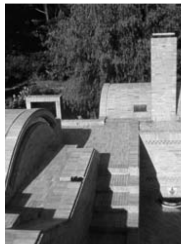
Figura 12. Vista de la cubierta desde el ala norte hacia el este.
