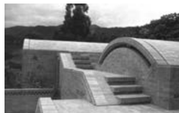
Figura 11. Escalera en la cubierta del ala norte.
