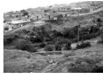
Figura 4. Quebrada La Medianía, lindero barrio El Portal del Divino. Manera informal e inconsciente de intervenir espacios de transición o ecotono natural, sin poder cohesionar lo urbano con el sistema ecológico.
