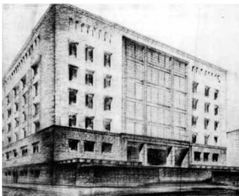
Figura 9. “Edificio Murillo Toro (1941)”.
