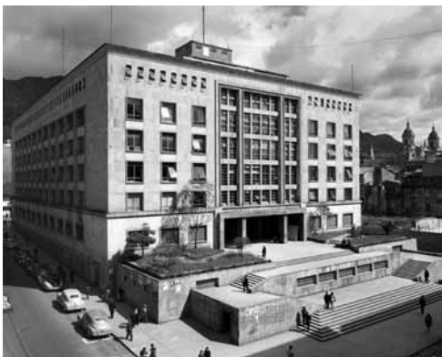
Figura 10. “Edificio Murillo Toro (1941)”.
