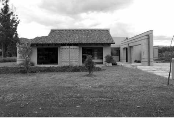
Fotos 11 y 12. Vivienda conjunto Pradera Potosí técnica mixta, estructura en concreto y cerramiento en BTC, La Calera, Cundinamarca Fotos: Andrés Mauricio González C.
