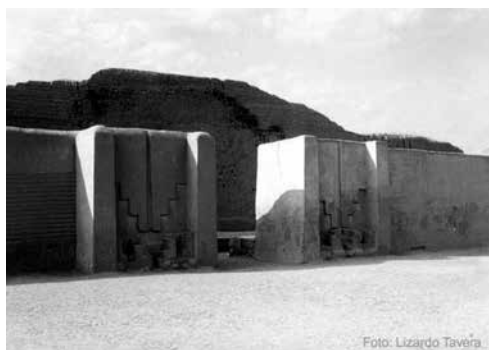
Foto 2. Ingreso principal a la plaza ceremonial, ciudadela de Tschudi.
