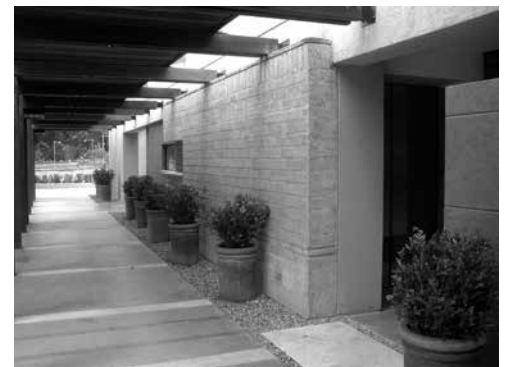
Foto 10. Muro en BTC Conjunto Pradera Potosí, La Calera, Cundinamarca Foto: Andrés Mauricio González C.
