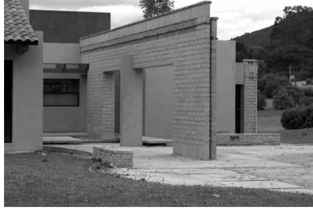
Fotos 11 y 12. Vivienda conjunto Pradera Potosí técnica mixta, estructura en concreto y cerramiento en BTC, La Calera, Cundinamarca Fotos: Andrés Mauricio González C.
