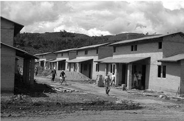
Fotos 13 y 14. Conjunto de viviendas VIS construidas con BTC en Sonsón, Antioquia Fotos: Fundación Tierra Viva
