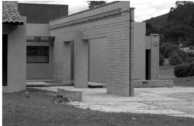
Fotos 11 y 12. Vivienda conjunto Pradera Potosí técnica mixta, estructura en concreto y cerramiento en BTC, La Calera, Cundinamarca Fotos: Andrés Mauricio González C.
