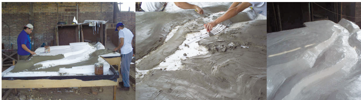
Figura 5. Aplicación de mortero y acrílico
