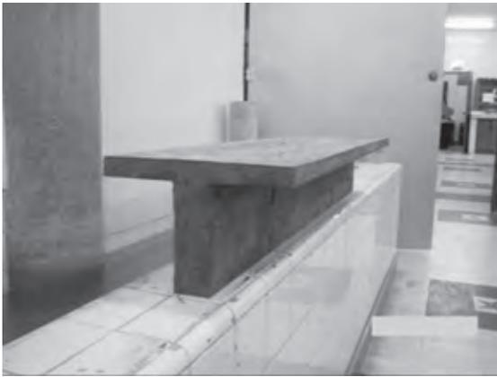
**Figura 22. Viga T ya terminada y lista para el proceso de curado**
