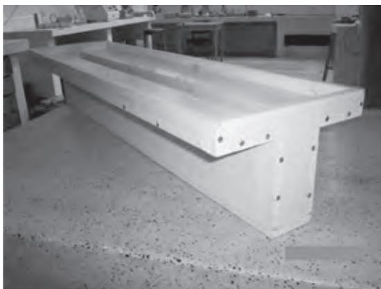
**Figura 19. Detalle de formaleta usada para la viga T**
