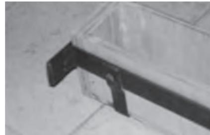
**Figura 12. Detalle de la modulación de la formaleta**
