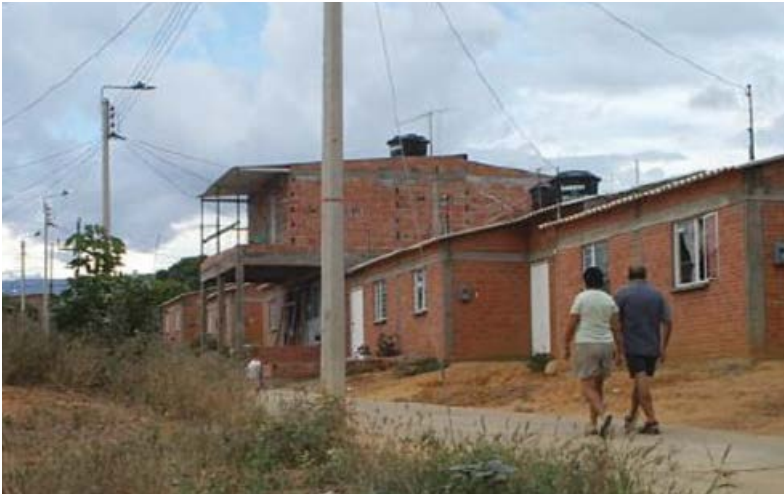
Figura 1. Ampliación a segundo nivel en viviendas del proyecto Torcoroma I
